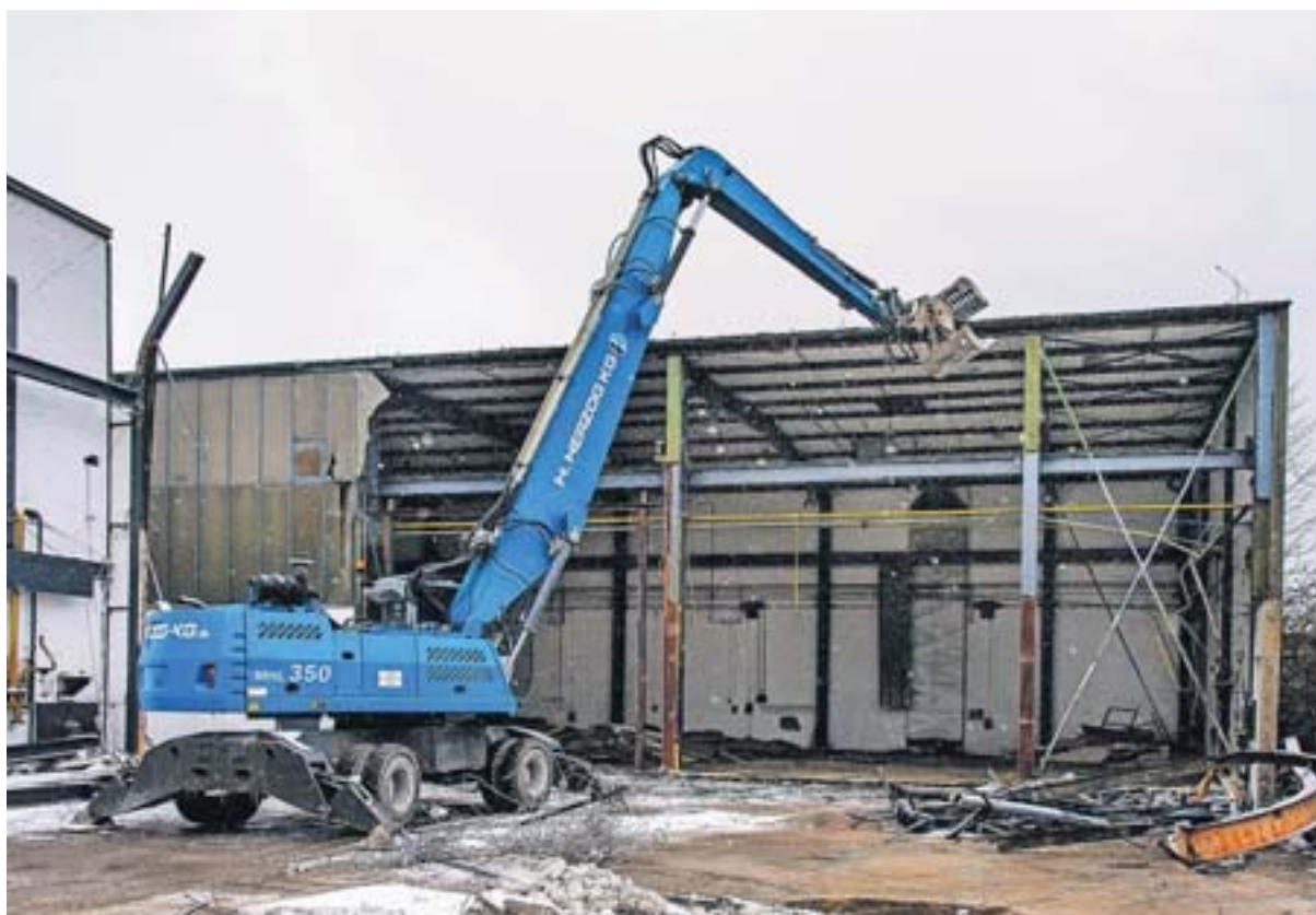
Bevor die Hochbauarbeiten beginnen können, müssen die alten Gewerbehallen weg. Bis das Areal freigeräumt ist, dauert es noch rund vier Wochen. Am 4. Mai soll die Grundsteinlegung gefeiert werden.
