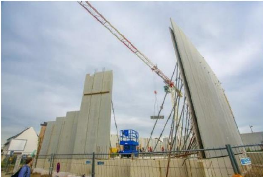
Die ersten Wände stehen bereits. Im November soll der Rohbau komplett sein. Foto: Chris Goettert
